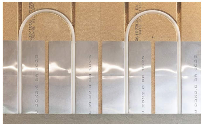
Figur 3 Värmefördelningsplattor till 16 mm värmeslangar, spåravstånd cc. 200 mm.
