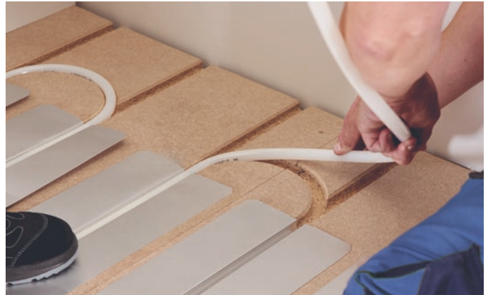
Figur 10 Montering av värmeslangar.
