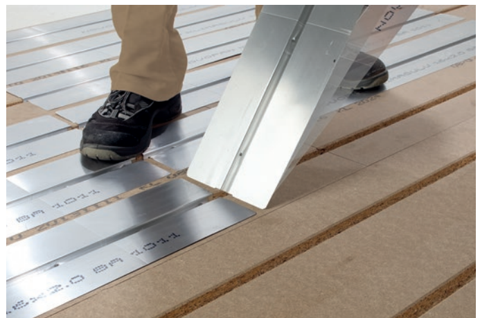
Figur 9 Värmefördelningsplattorna kan monteras stående.
